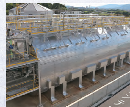
メタン発酵槽 選別された生ごみ等が発酵槽の中で微生物の働きにより分解されることで、メタンを主成分とするバイオガスが発生します。
