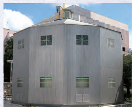
ガスホルダ 発生したバイオガスを一時貯留するものです。
