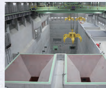
バイオガス化ホッパ ごみピットの燃やすごみをごみクレーンでバイオガス化施設用のホッパに投入します。
