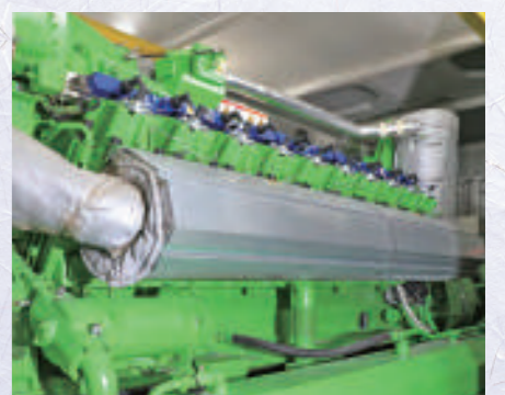
ガスエンジン バイオガスを燃料としてエンジンを動かし、発電を行います。出力は最大1,000kWで、年間発電量は、一般家庭の年間消費電力量のおよそ2,000世帯分です。
