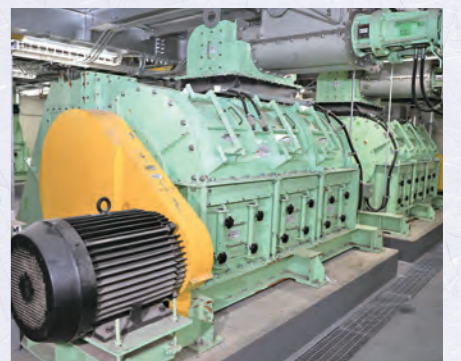
選別装置 細かく砕いたごみから、軽いプラスチックなど、発酵に不適なものを取り除きます。
